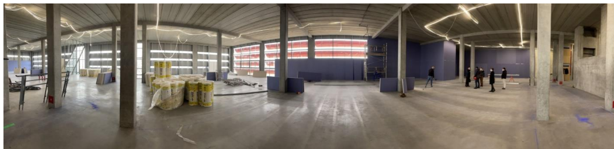
Photo 1 : Aménagement d'un plateau de 1600 m 2
